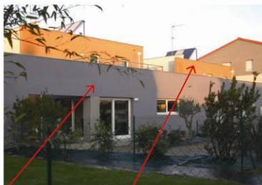
Façade commune aux deux maisons
