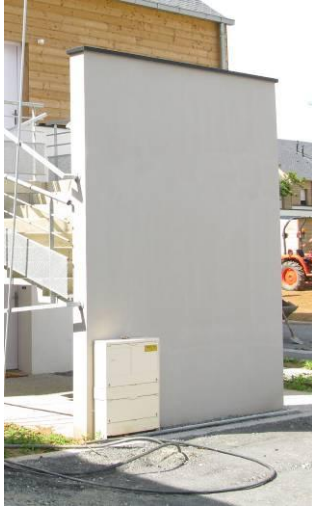
Les coffrets devront être intégrés
